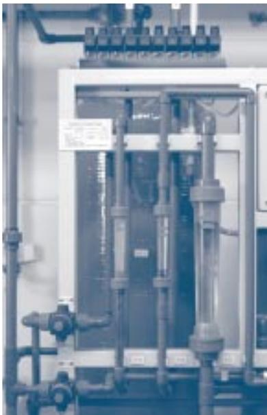
Bei der Regenerierung der Austauscher fallen Eluate an, die in der Abwasserbehandlungsanlage entsprechend weiterbehandelt werden müssen. Ionenaustauscher haben verhältnismäßig lange Betriebszeiten. Gesättigte (beladene) Ionenaustauscherharze können mehrfach betriebsintern oder extern (z. B. über den Anlagenhersteller) regeneriert werden.
